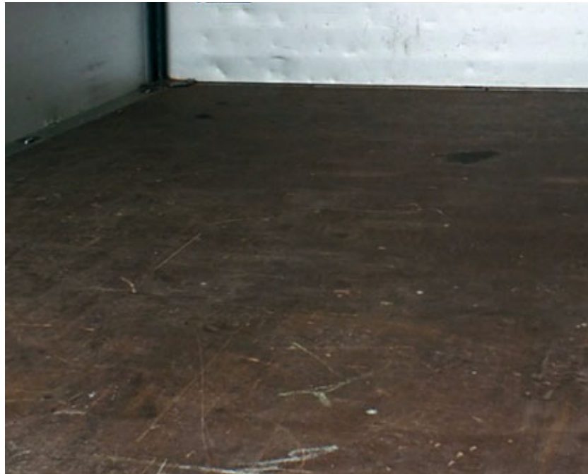
Nutzungsbedingte Kratzer Laderaumboden
